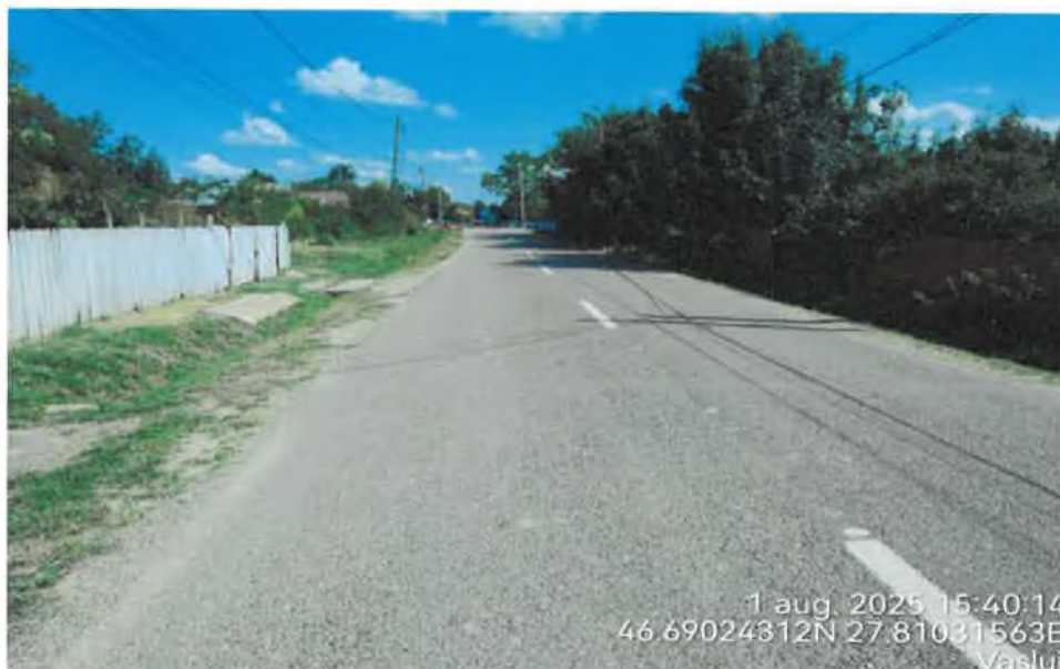
Foto 02. Situatia existenta pe DJ244K-zone cu suprafata poroasa , siroita
