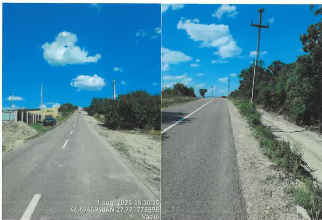
Foto 04. Situatia existenta pe DJ244K-zone cu rupturi la margine si fagase longitudinale
