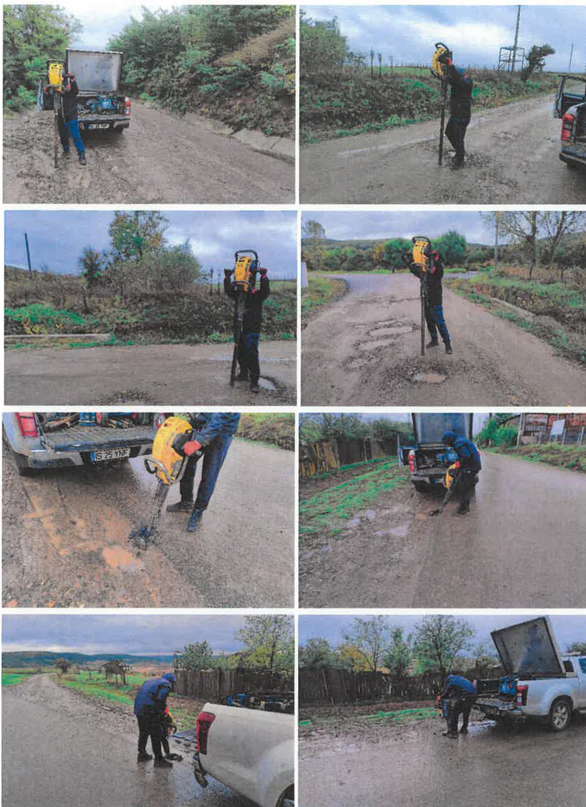
Figura 18. Realizare foraje geotehnice
