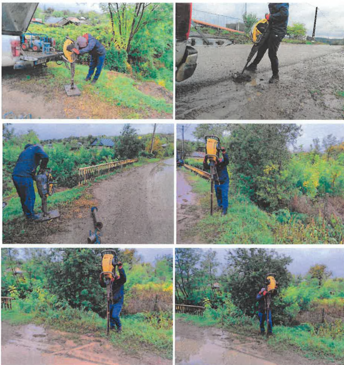
Figura 19. Realizare foraje geotehnice
