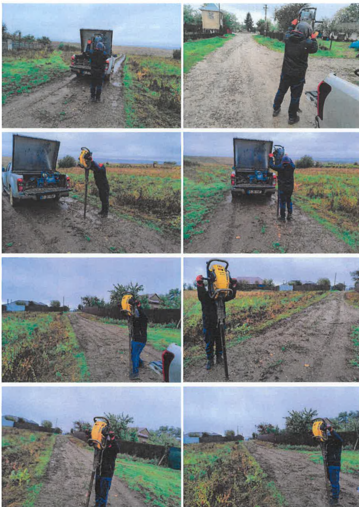
Figura 16. Realizare foraje geotehnice
