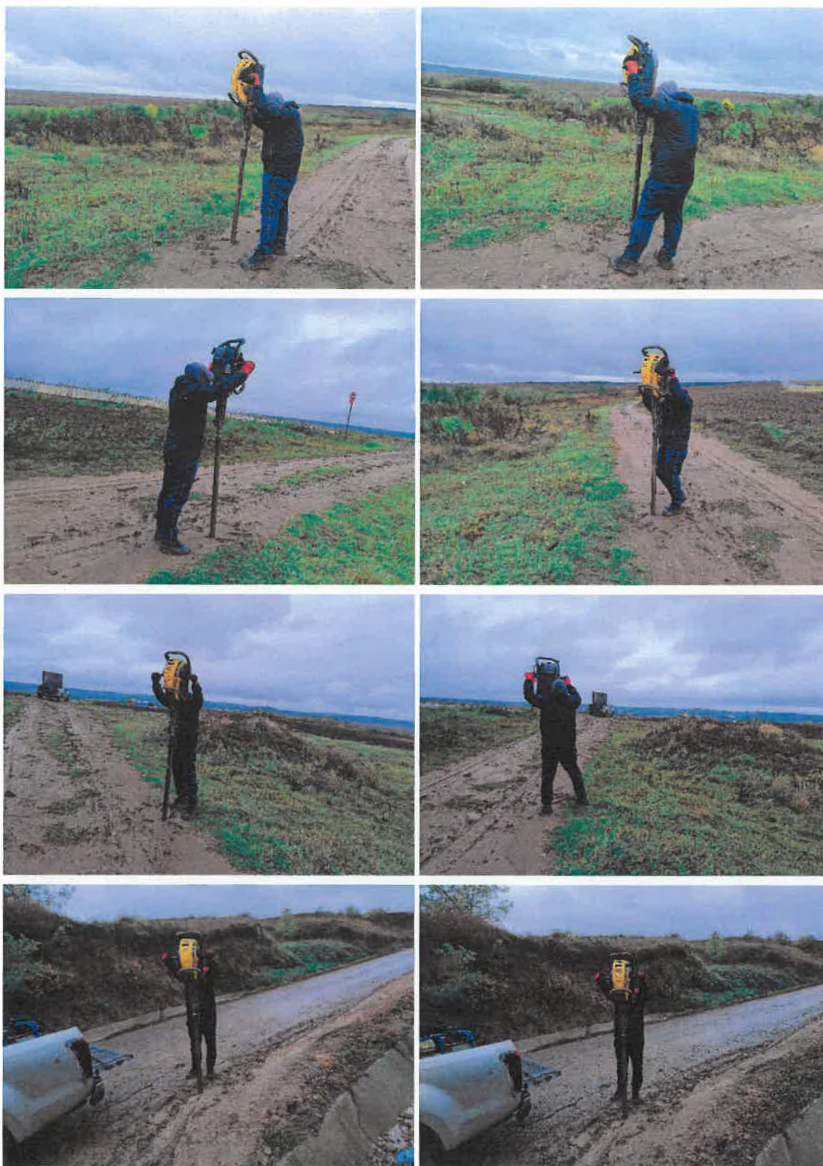
Figura 17. Realizare foraje geotehnice
