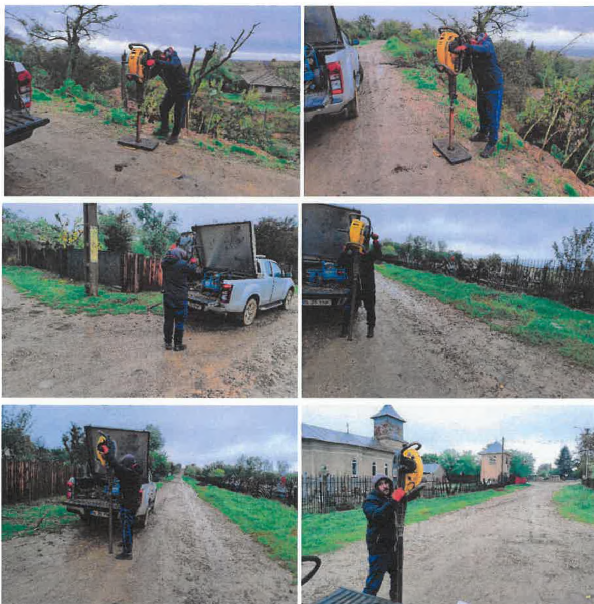
Figura 15. Realizare foraje geotehnice
